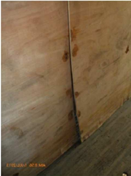
Laminas de plywood levantadas
