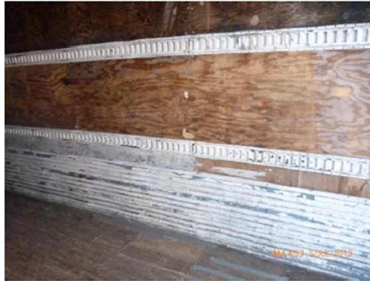
Laminas de metal en paredes de furgón
